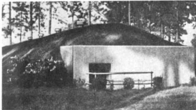
Bunkeranlage eines Versorgungsdepots [Bild 874.5]
