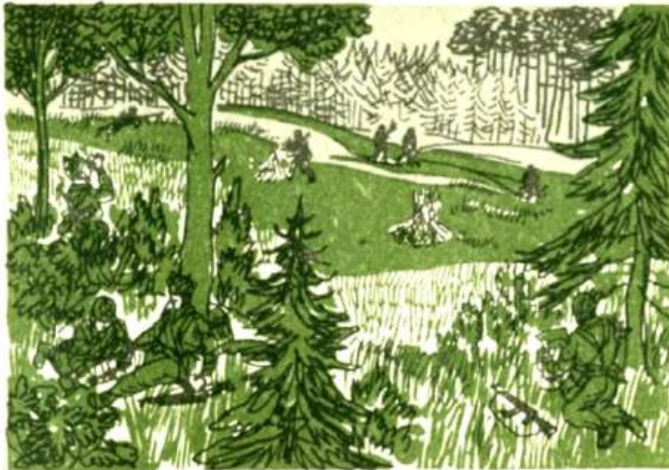
Vorbereitung des Hubschrauberlandeplatzes [Bild 633.4]
