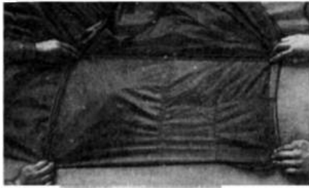
Legen der Bahn Nr. 17 und Ablegen in Richtung Schei- tel [Bild 616.24]
