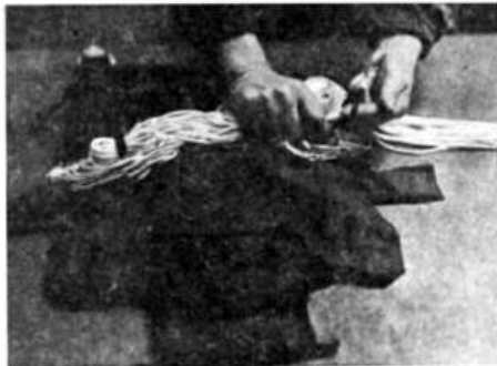
Einschlaufen der Fangleinen (erste Schlaufe) [Bild 617.15]
